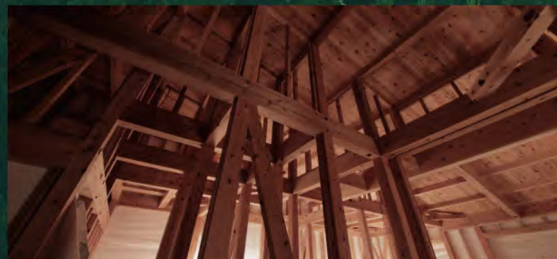
独自の乾燥方法で木の余分な水分だけを抜く「音響熟成木材」を使用。木が持っている油分やエキスをいかした、木材強度が高くしなやかで地震に強い生きた木材です。
